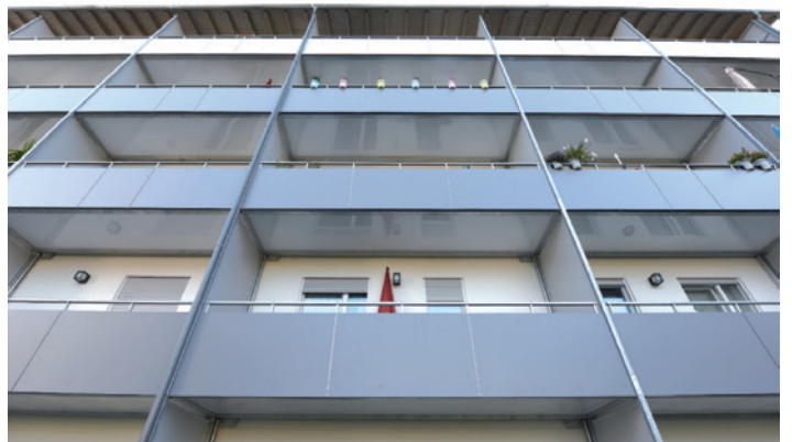
Spittelmeister-Systembalkone als Vorstellbalkone am Neubau. Die Geländerfüllungen und Sichtschutzwände wurden mit Trespa-Platten ausgeführt. Edelstahlhandläufe runden die hochwertige Optik ab.
