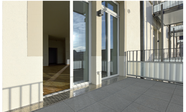
Spittelmeister-Systembalkone aus Aluminium. Die Balkongeländer sind aus Stahl mit einem 60 cm hohem Sichtschutz (seniorengerechte Ausführung).
