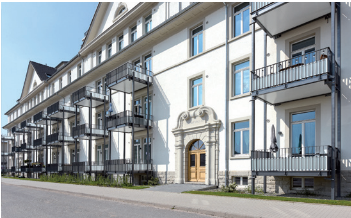
Balkonanbau von Vier-Stützen-Anbaubalkonen nach Umnutzung. Alle Balkone sind barrierefrei.
